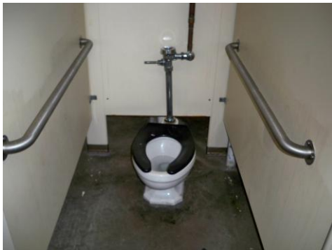
Non ADA Compliant restroom
